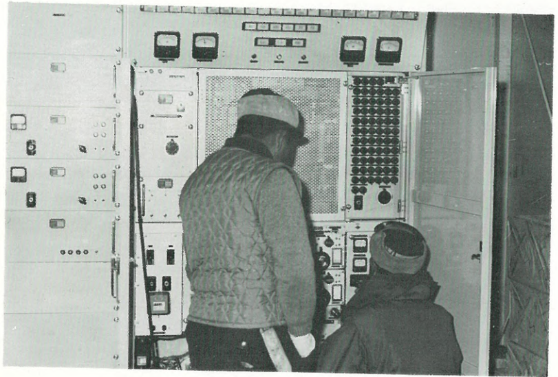
第 3 図 昭和基地局の 1 kW, SSB 無線機
