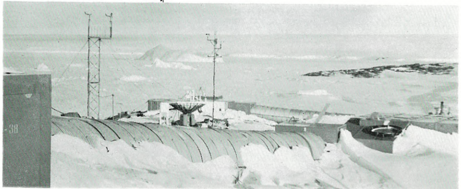
昭和基地 ■通信棟より新発電棟を見るコルゲート通路
