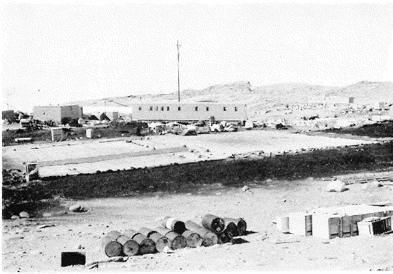
第 9 居住棟, 手前がヘリポート
