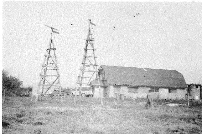
第4図 山田式風力発電機の設置状況
