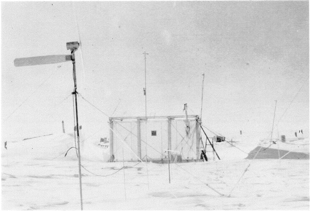
写真-2 内陸基地での風力発電機設置状況
