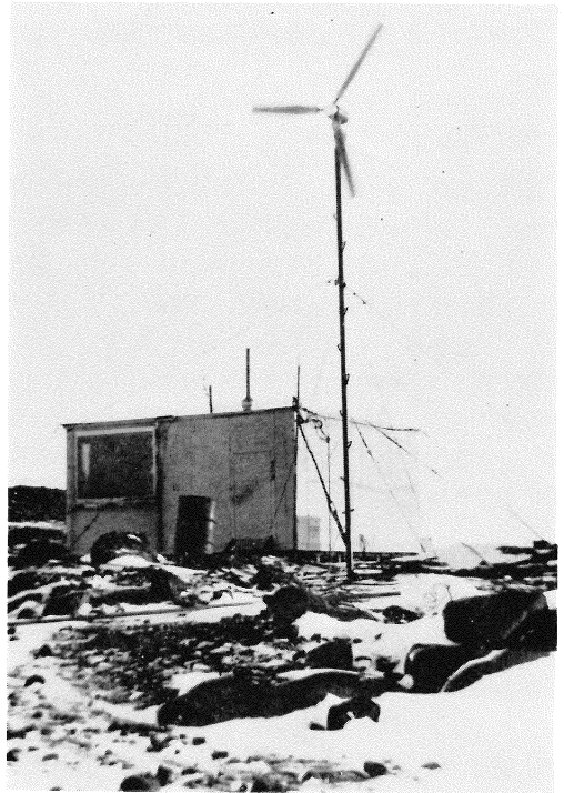
写真—1 昭和基地での風力発電機設置状況
