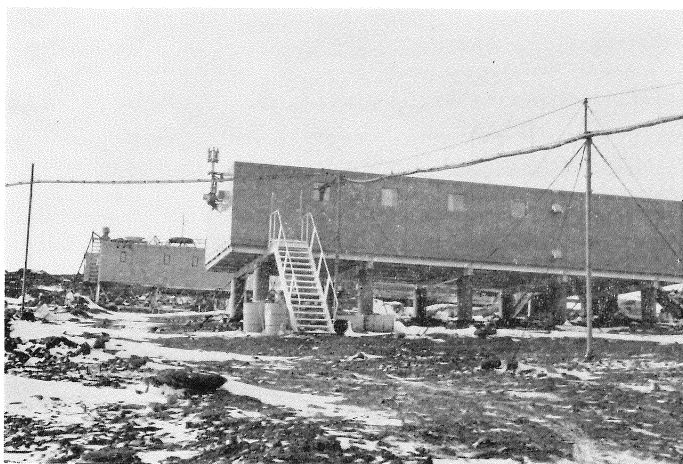
写真—4 環境科学棟、建物より右にのびている線は給水パイプ、左にのびているのが排水パイプで海におとしている
