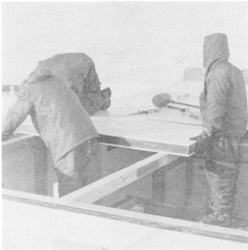
写真-2 みずほ観測拠点における居住棟の建設作業
