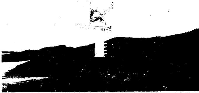
写真一4 昭和基地に新設された人工衛星テレメータ受信自動追尾アンテナ
