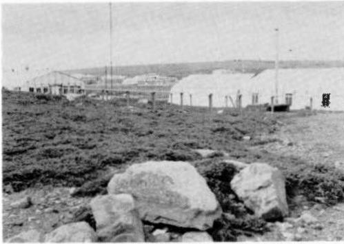
写真-2 基地の建物。古い鉄板組立住宅と近代的なパネル組立住宅とからなっている。個室は各建物内に分散している。(Kerguelen)
