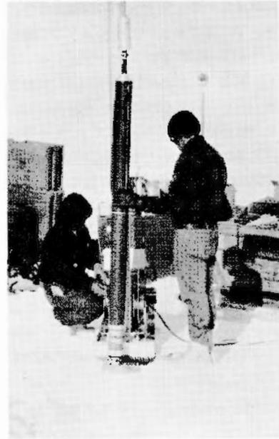
写真-7 スリップリングに吊下げたドリル上部（回り止め部、駆動部、連結部）
