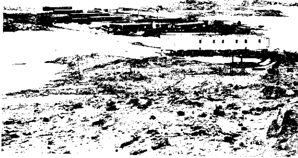
建設作業の始まった昭和基地
