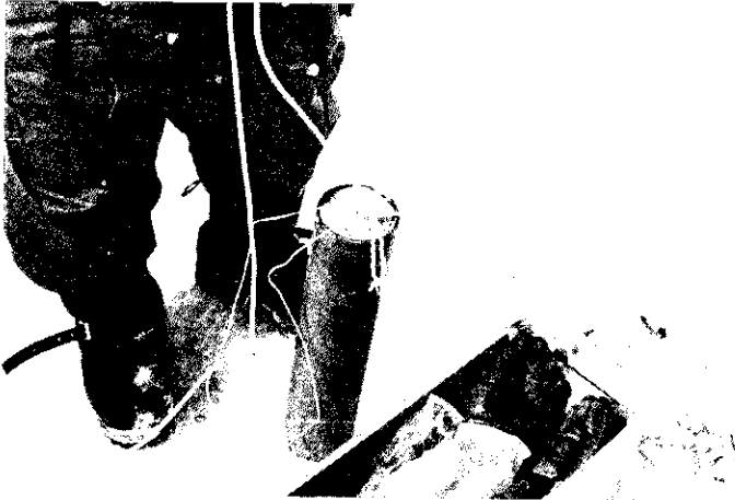
写真-6 雪氷爆破用の親ダイ（雷管をセットしたダイナマイト）。
